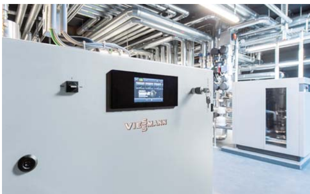
Das Blockheizkraftwerk Vitobloc 200 EM-6/15 hat eine Leistung von 6 kW el und 15 kW th .
