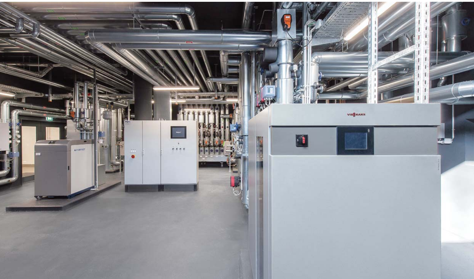
Die Großwärmepumpe Vitocal 300-G Pro hat eine Heizleistung von 82,8 kW.
